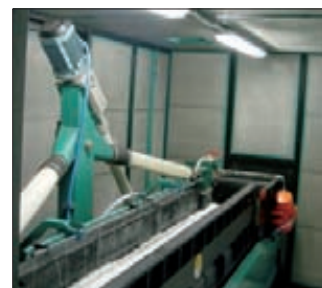
Un impianto Ecodec di Rollwasch Italiana, recentemente avviato presso un'importante azienda in Irlanda.
